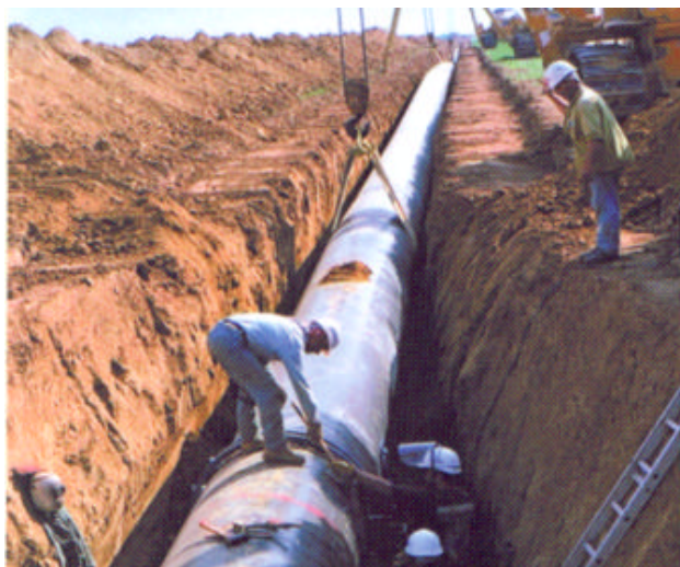
Técnicos de radiologia industrial preparando a radiografia de uma junta soldada circular de uma tubulação numa vala, antes desta ser liberada.
